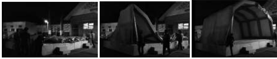
Gambar 6. Pemasangan Atap Panggung Inflatable (6 menit)
