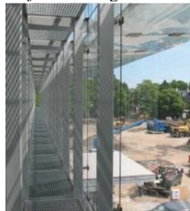
Gambar 11. Ruang atau jarak antara double-skin facade bangunan dengan jendela
