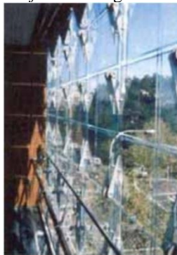
Gambar 14. Ruang atau jarak antara double-skin facade bangunan dengan jendela
