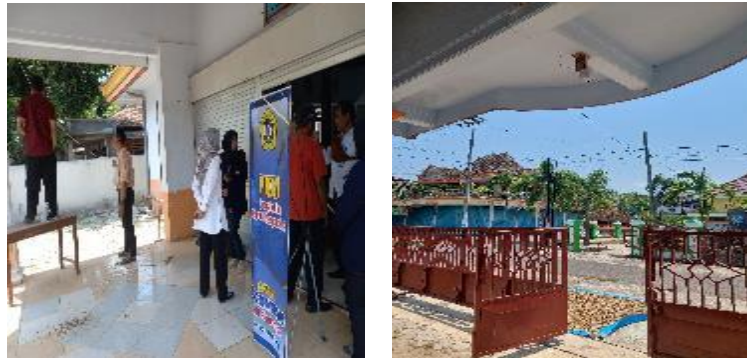
Gambar 6. Pemasangan CCTV di depan Balai Desa
